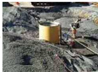
埋戻し・仕上げ (3日) 規定土被りまで埋戻し。
