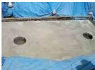
基礎コン打設 (2日) 栗石止め高さまで打設。
