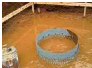
栗石止め設置 基礎レベルに合わせ設置。 ピットの位置を決める。
