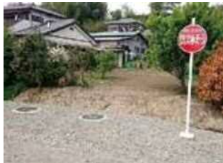
群馬県みなかみ町 山間部の狭小地に設置。 れき、岩も多く開削設置に適している。
