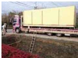
搬入・溶接 (1日) 養生期間後、搬入。ラフタークレーンは 一体型で25t、2分割で16tを使用。
