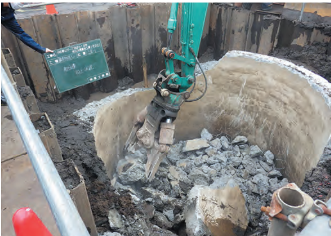
写真 鋼矢板による土留めの状況(従来の撤去工事)
