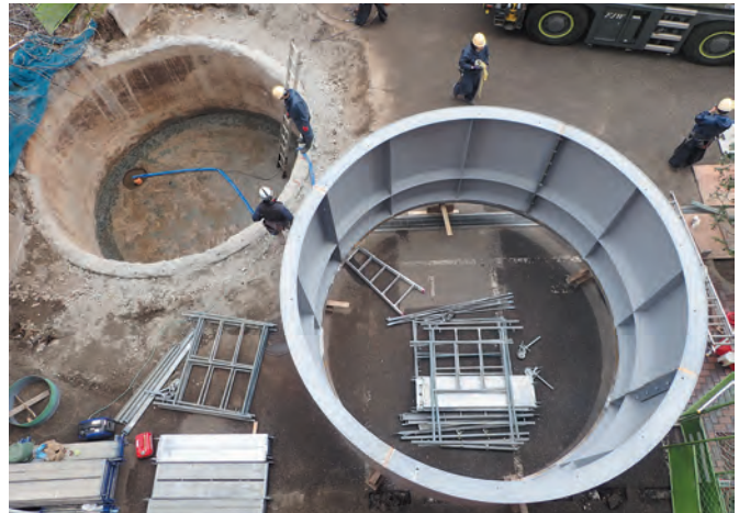
写真 既存防火水槽の躯体が土留めを兼ねている状況（TIT工法）
